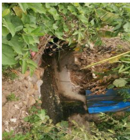
建设路排涝通道现况图
