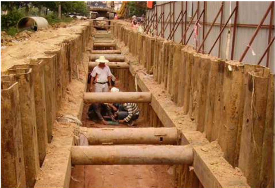
图 5.1.6-1 钢板桩支护图
