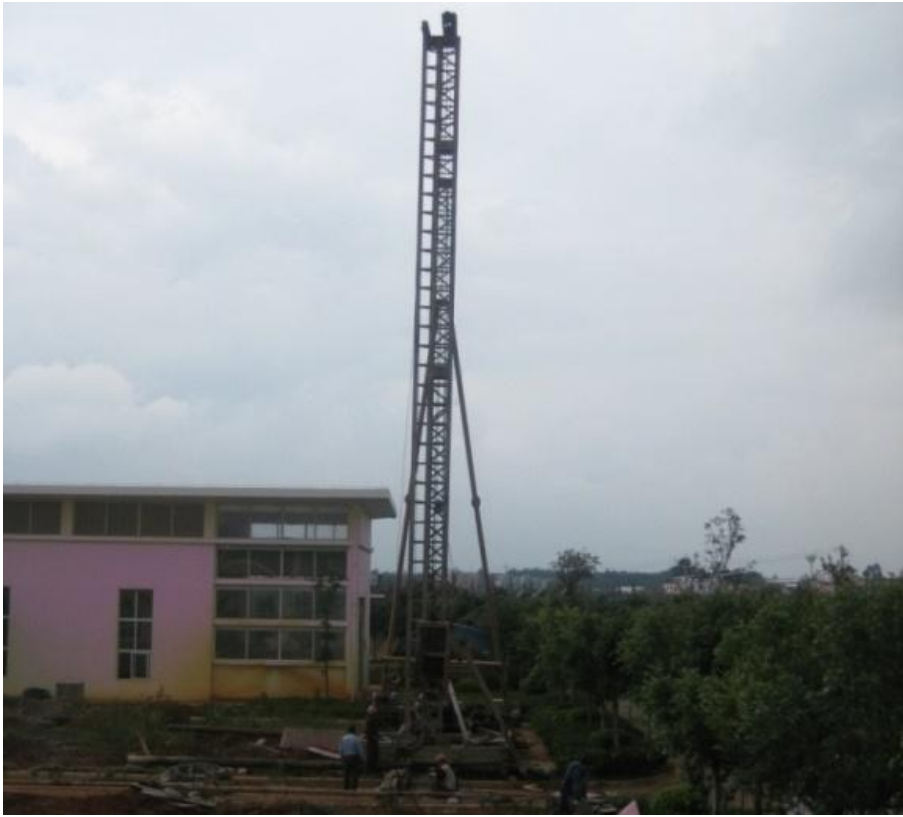
图 1.8.8-4 水泥土深层搅拌桩现场图
