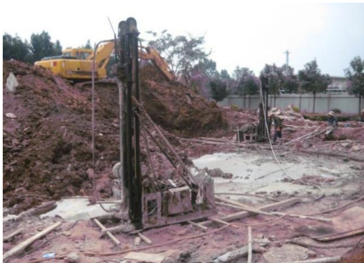
图 1.8.8-5 高压旋喷桩示意图及照片
